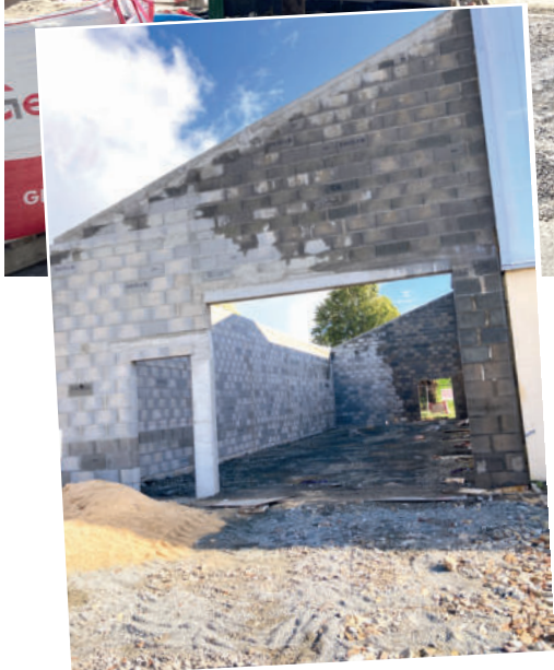
Le local rangement adossé à la salle des sports
